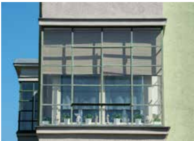
Detail am Norderneyer Weg von Süden
