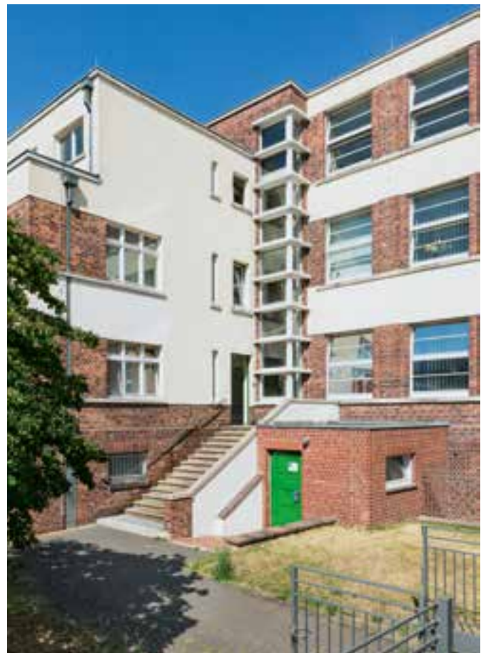
Detail des Hauptgebäudes von Südwesten
