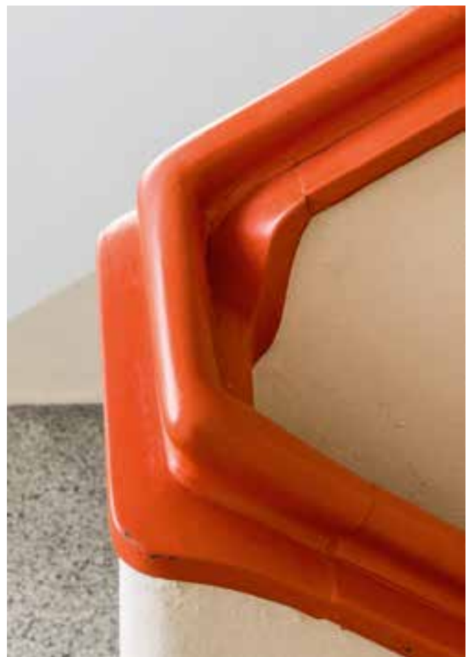
Detail aus dem Treppenhaus
