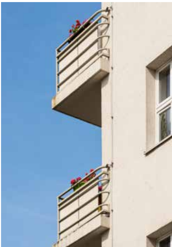
Gebäudeecke mit Balkonen
