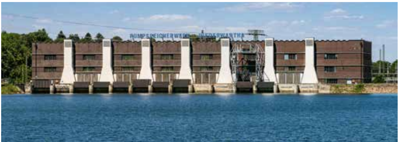
Maschinenhaus und unteres Speicherbecken von Südosten
