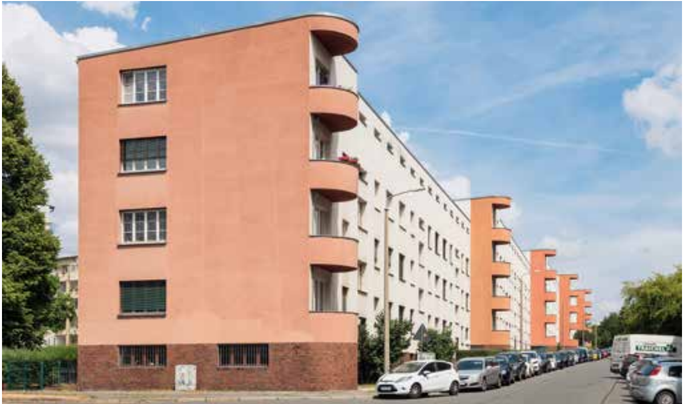
Blick in die Faradaystraße von Südosten
