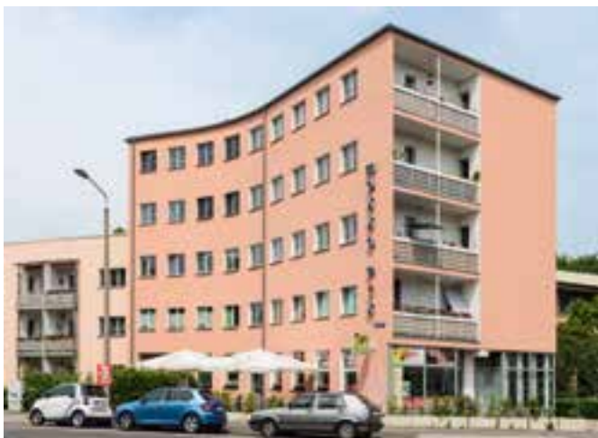
Ecke Industriestraße /Kopernikusstraße von Südosten
