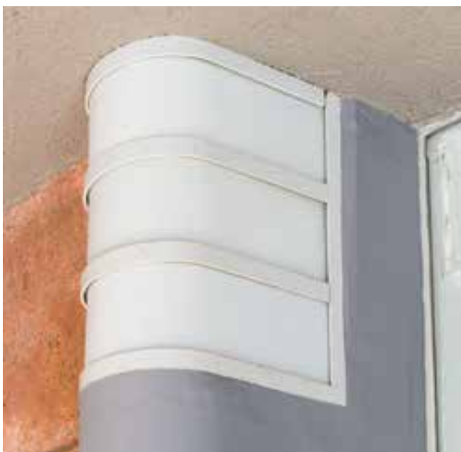
Lampendetail im Eingangsbereich
