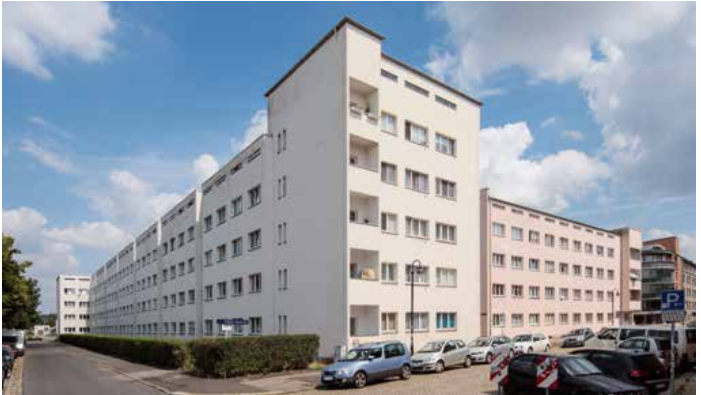
Ecke Arno-Lade-Straße / Robert-Matzke-Straße von Südwesten
