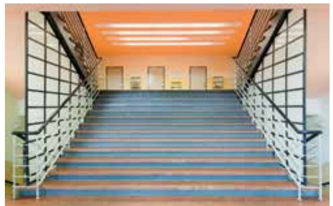
Haupttreppenhaus, Blick vom Zwischenpodest zum 1. Obergeschoss
