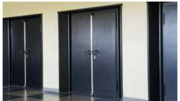
Aulatüren von außen
