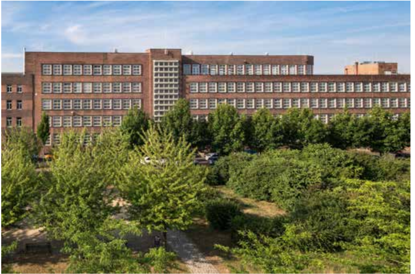
Gesamtansicht von Norden
