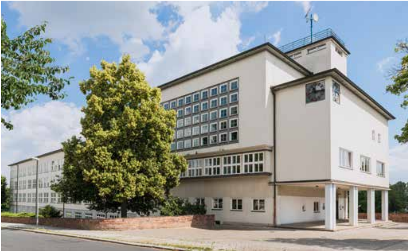
Hauptansicht von Süden
