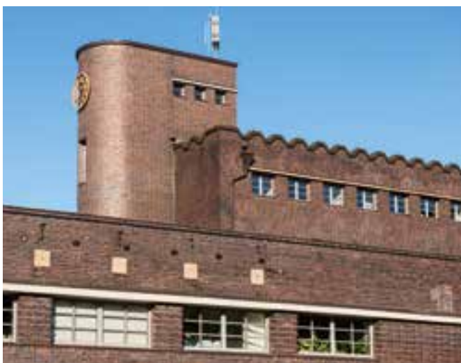
Verwaltungsgebäude mit Treppenturm
