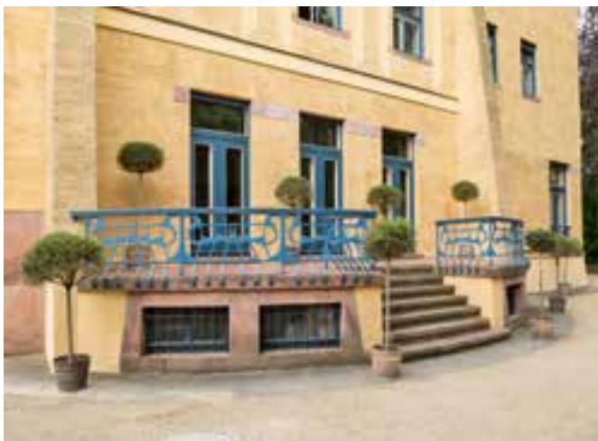
Terrasse an der Westfassade
