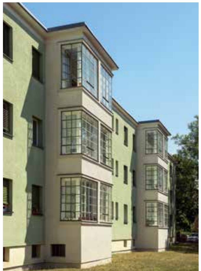
Rückseite am Norderneyer Weg von Nordwesten
