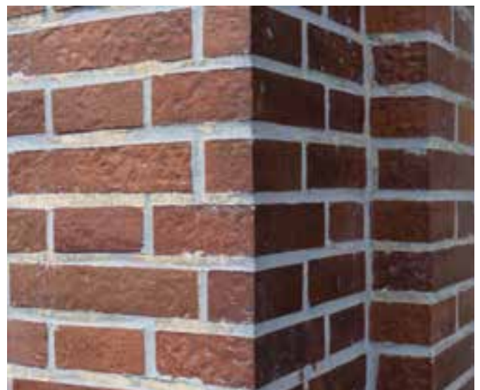
Mauerwerk mit blauen Fugen
