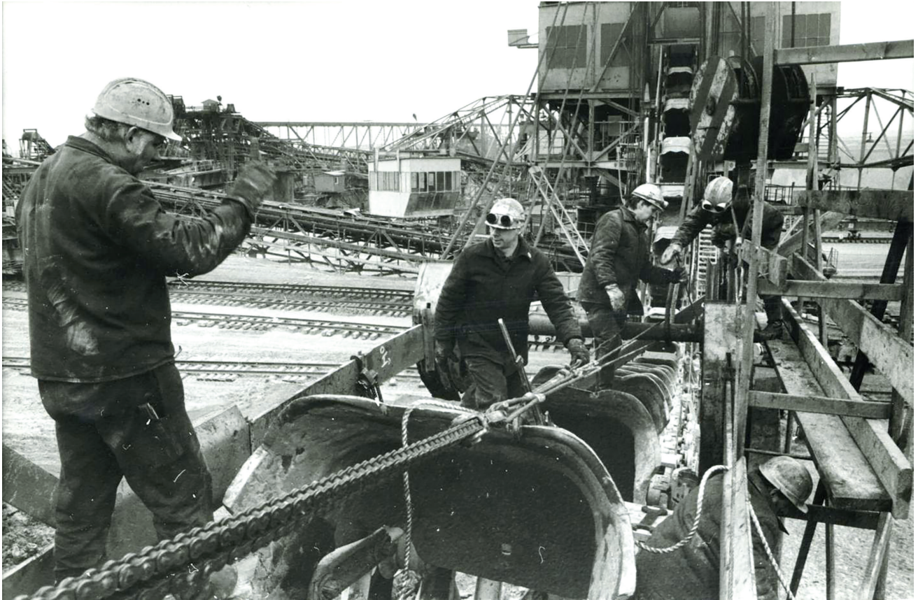
Bild ▲ Mitarbeiter am Kettenbagger im Tagebau Espenhain, 1980er Jahre. Foto: Archiv Rudolf Lehmann
